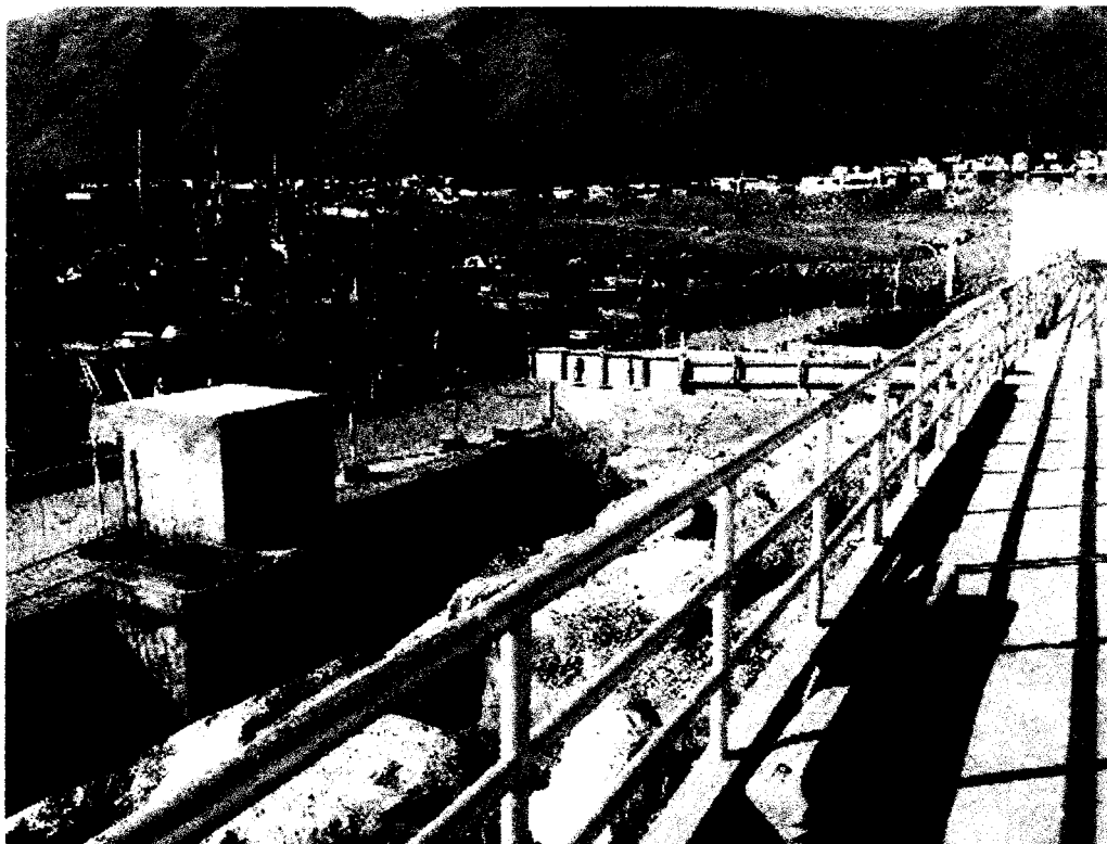
Fotografía N°07: Vista de área de rampas paralizada injustificadamente por el contratista.
